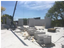
Plaatsen kalkzandsteenwanden 1 e etage
