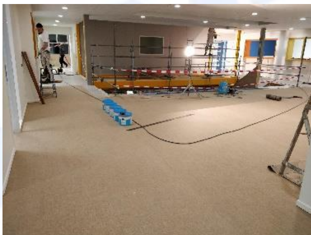
Kurkement vloer op de verdieping
